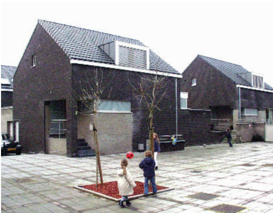
SHM Kleine Landeigendom Tongeren – Brugstraat in Smeermaas, vervangingsbouw van 11 woningen (reeks A).
