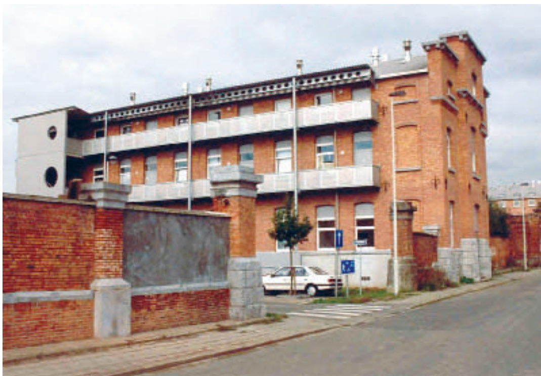
SHM 'Volkswoningen van Duffel' – Lintsesteenweg in Kontich, renovatie van 22 appartementen en 4 duplexen.
